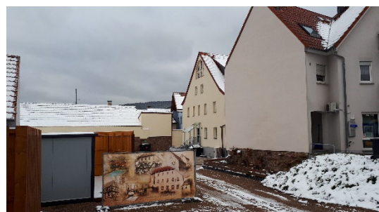
Brandwand Hauptstraße 25 mit Durchfahrsmöglichkeit zum Biergarten des Gasthauses „Zum Ochsen“
