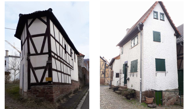
... auch kleine Gebäude prägen das Ortsbild
