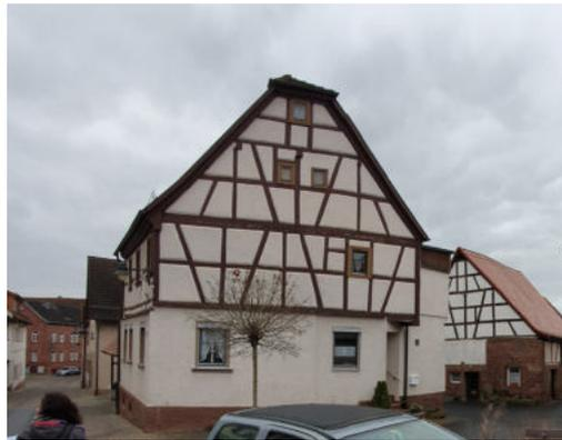
Abb. 121: Fachwerkgebäude mit Satteldach und hochliegendem Kellergeschoss, Hauptstraße
